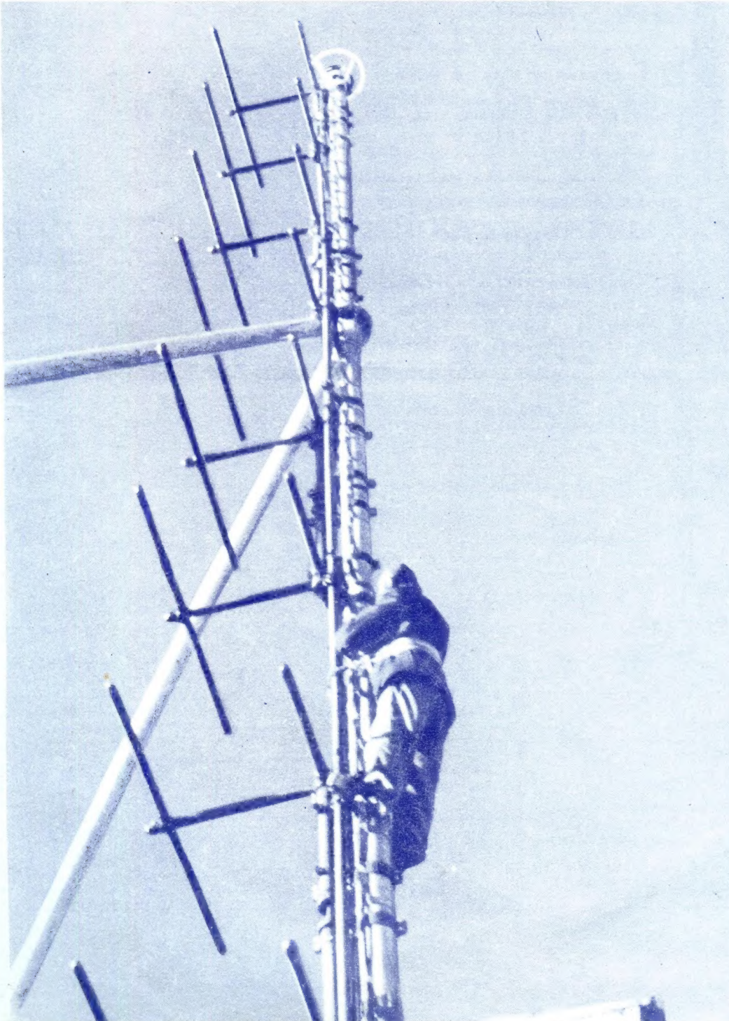
Auf dem Wendelstein wurde zur Erhöhung der vertikalen Bündelung und der Empfangsfeldstärke eine neue, von der Firma Rohde & Schwarz gebaute 8fach-UKW-Dipol-Reflektor-Antenne aufgestellt. Der Wendelstein-Sender überträgt das Programm des Bayerischen Rundfunks auf 89,3 MHz. (Foto: Kreis).
